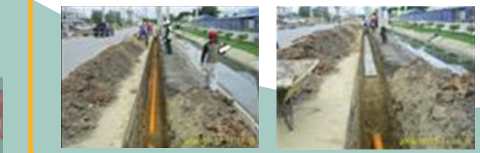
การวางท่อแบบขุดเปิด
